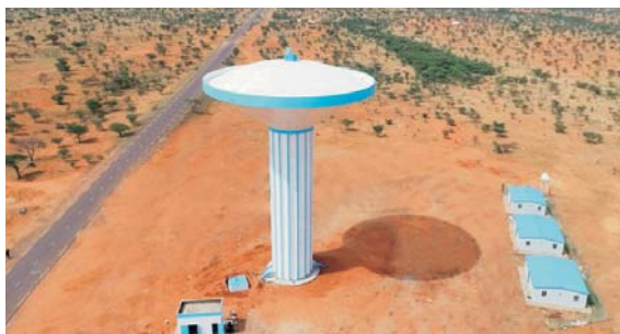
Projet d'alimentation en eau potable dans la région du Dhar (Mauritanie)
