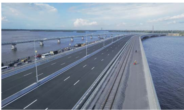
2ème Pont sur le Wouri (Cameroun)
