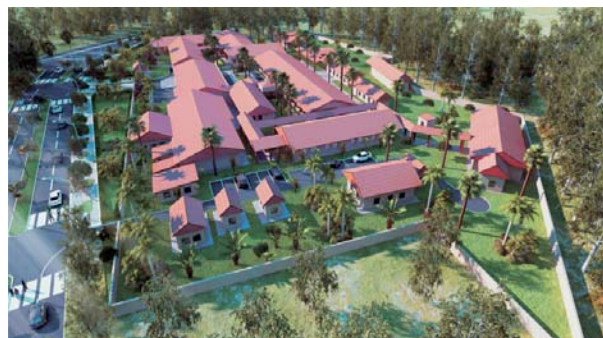
Rénovation et mise à niveau du Centre Hospitalier Régional de Guiglo (Côte d'Ivoire)
