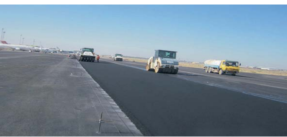
Parkings et bretelles de l'aéroport international Hassan Djamous de N'djamena (Tchad)
